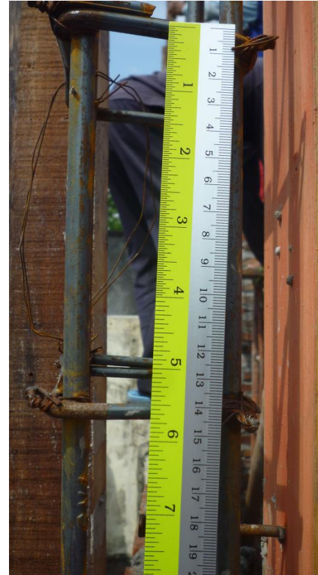
帯筋間隔: 約15cm (主筋は全部丸鋼)
